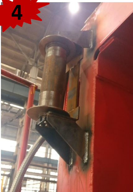
КПМ. Приварка элементов на окрашенные поверхности, еще раз красим
