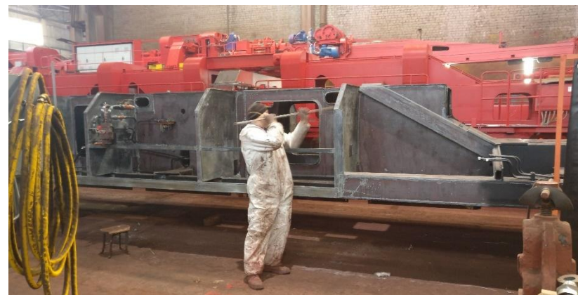
КПМ. Хранение листов на улице привело к коррозии металла, зачистка происходит уже на сборке крана
